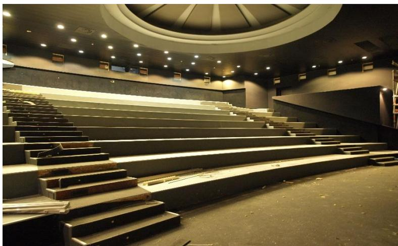
Entkernung von drei Kinosälen und Nebenräumen, Rückbau von textiler Wand- und Deckenverkleidung, Entfernung aller verklebten Bodenbeläge, Demontage der Saaltechnik und Beschallungsanlage. Trennung der Materialien und Zufuhr zur Entsorgung.
