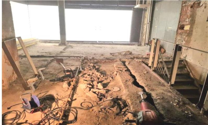
Entfernung von Bodenaufbau aus Gussasphalt, Bauschuttentsorgung (ca. 30t) unter stark beengten Raumverhältnissen, Schaffung von Decken-durchbrüchen in Betondecke.
